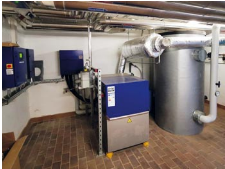
Energiezentrale I Landratsamt Forchheim
