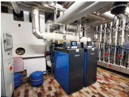
Energiezentrale II, Doppelkesselanlage Landratsamt Forchheim
