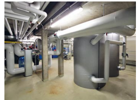
Energiezentrale, Ehrenbürg Gymnasium, Forchheim
