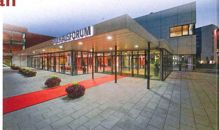
Das Ballhausforum der Stadt Unterschleißheim wird seit 2007 von der Südwärme mit Energie versorgt.
