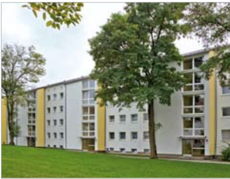
Wohnanlage Petrarcastraße, München
