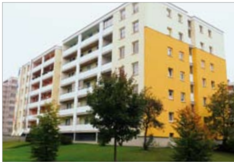
Wohnblocks Droste-Hülshoff-Straße, Augsburg
